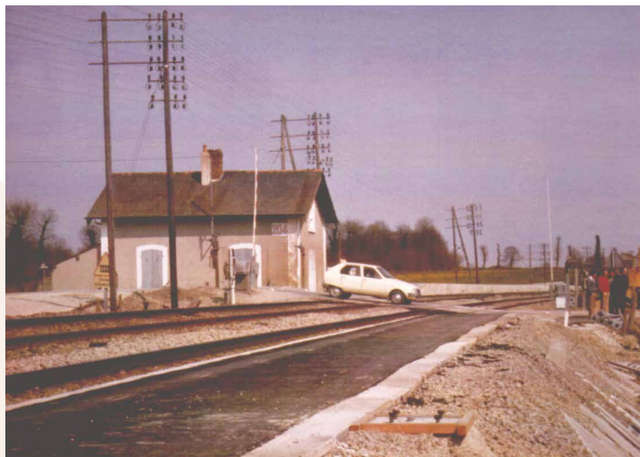
LE PASSAGE À NIVEAU DES SENTIERS LORS DES TRAVAUX D'AMÉNAGEMENT DE LA HALTE SNCF EN 1980 (CLICHE B. MONVOISIN).
