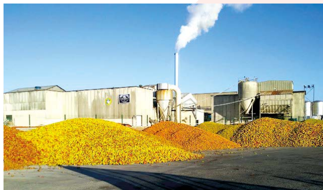
5 L'USINE DE DOMAGNÉ EN 2018.
